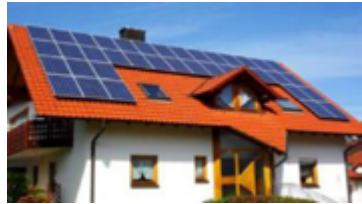
Pannelli solari da tetto
